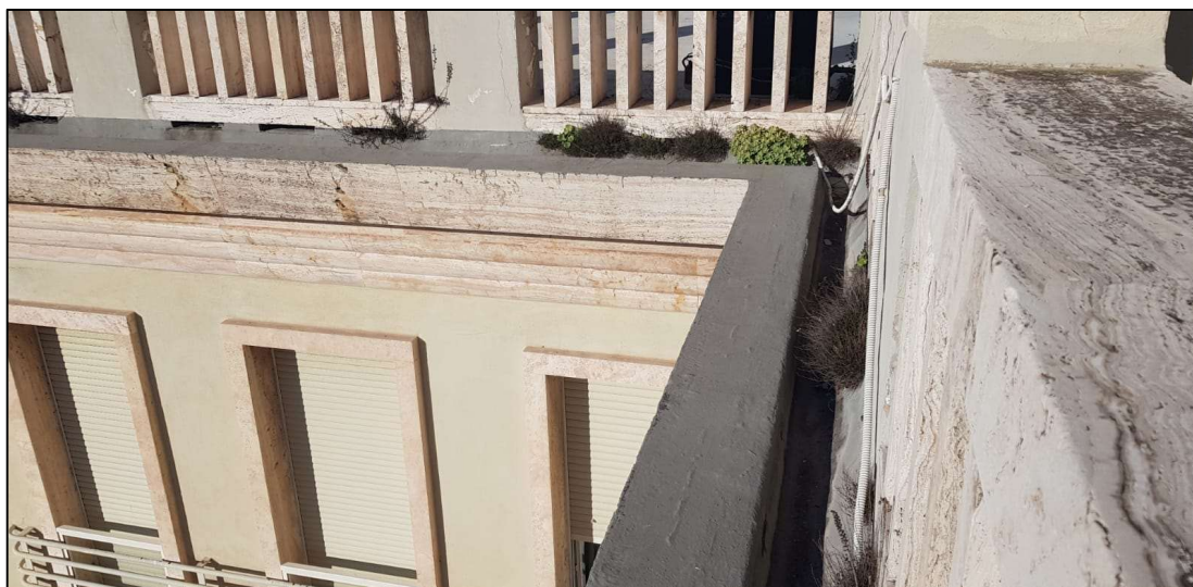
Figura 13: canali di affluenza dell’acqua verso i canali di gronda (lato esterno parapetto)
