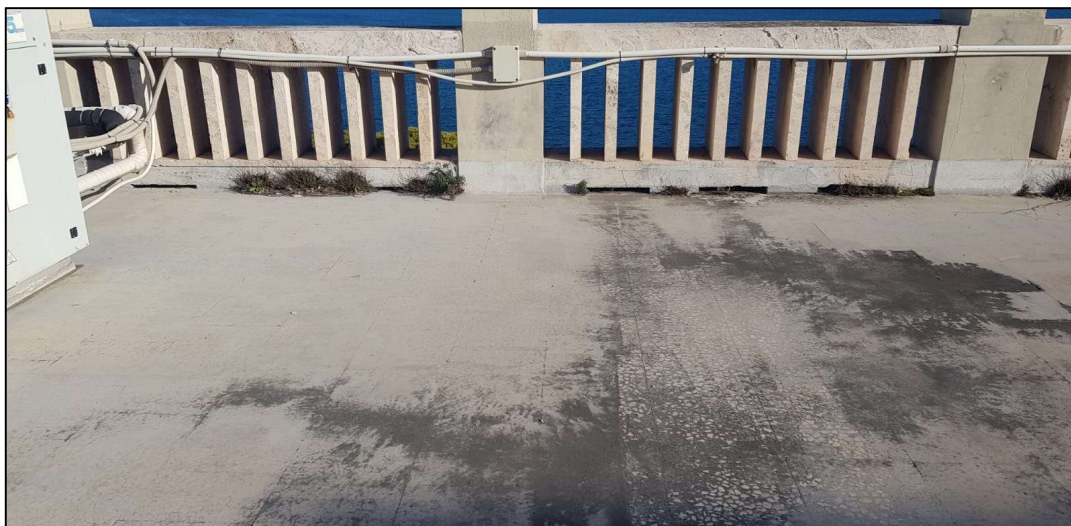
Figura 16: guaina bituminosa degradata con rilievo in vista della pavimentazione sottostante (zone rosse)
