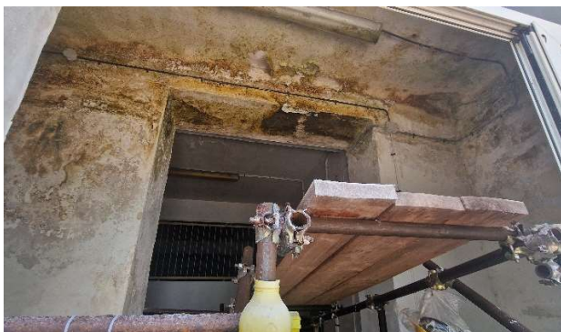
Foto 5 – Dettaglio del ponteggio a tubi e giunti
