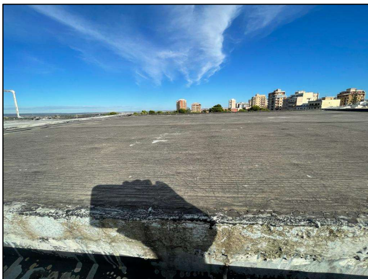
Figura 15: guaina bituminosa vetrificata e priva di risvolto in corrispondenza dei solai rialzati (zona gialla)
