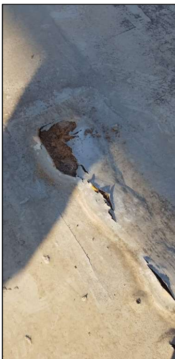
Figura 17: sollevamento e distacco della guaina dalla pavimentazione sottostante
